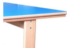
Assemblage par vis plot
